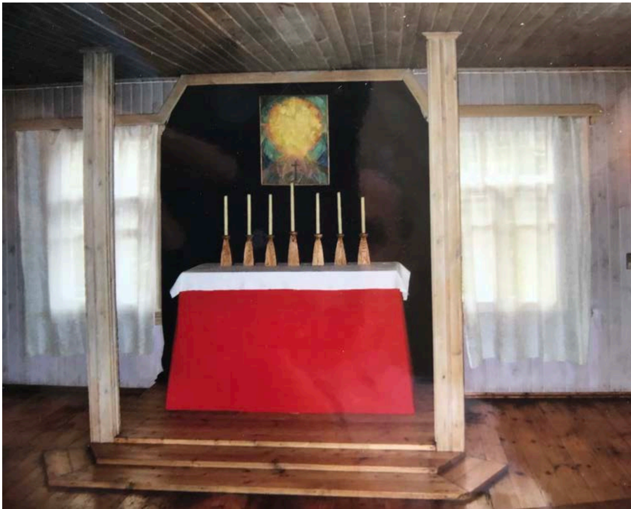
Mit viel Liebe haben sie sogar drei Stufen gebaut. Die beiden Säulen tragen das obere Stockwerk. Katja hat das Altarbild gemalt.
